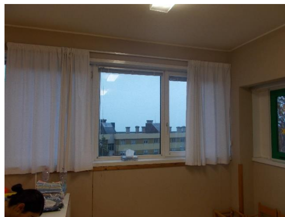
Figura 4.4 - Particolare dei serramenti
