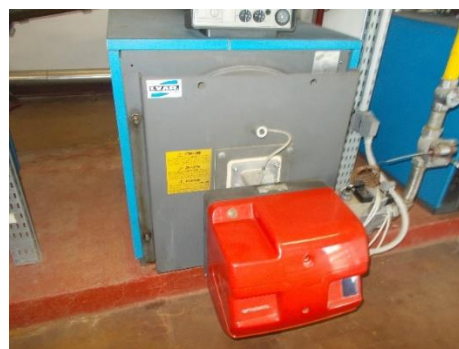
Figura 4.10 - Particolare di una caldaia tradizionale per la produzione di acqua calda sanitaria
