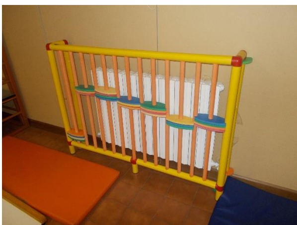
Figura 4.6 – Particolare dei radiatori
