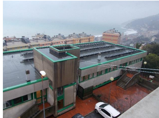
Figura 1.1 - Vista della facciata
